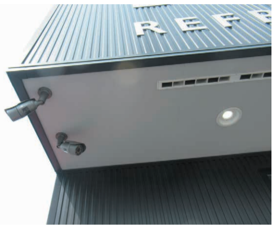
▲このコインには合計6台のカメラがあり、店外の2台は入り口と駐車場を映す
